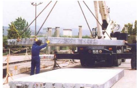
Einheben der mit Beton ausgegossenen MSBW-Stahl-Brückenmodule
