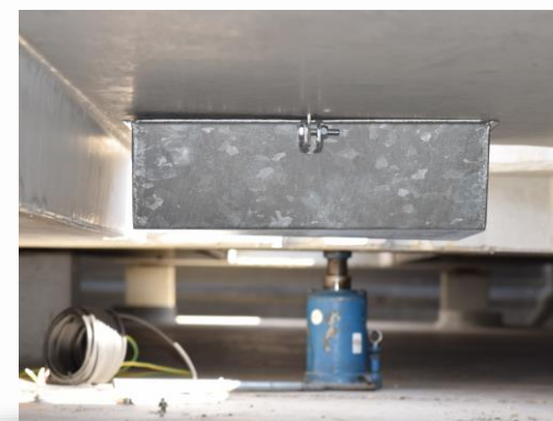
Stirnseitiger Kanten- und Eckenschutz aus verzinktem Stahl
